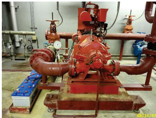
เครื่องสูบน้ำดับเพลิงชั้นใต้ดิน และตู้ควบคุม
