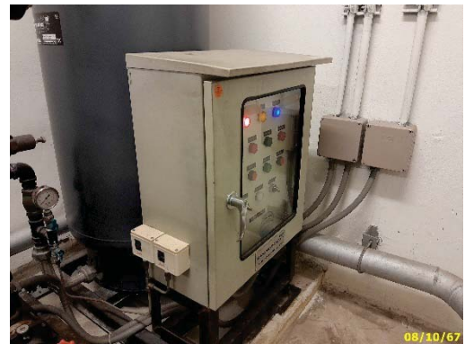
เครื่องสูบน้ำชั้นดาดฟ้า และตู้ควบคุม
