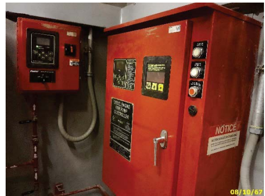
เครื่องสูบน้ำดับเพลิงชั้นใต้ดิน และตู้ควบคุม
