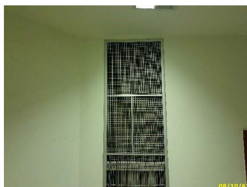
ระบบระบายอากาศของโรงลิฟต์ดับเพลิง
