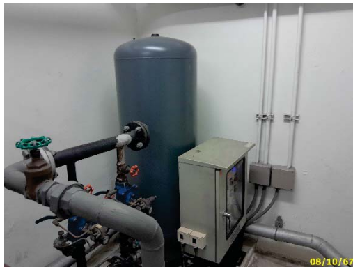
เครื่องสูบน้ำชั้นดาดฟ้า และตู้ควบคุม
